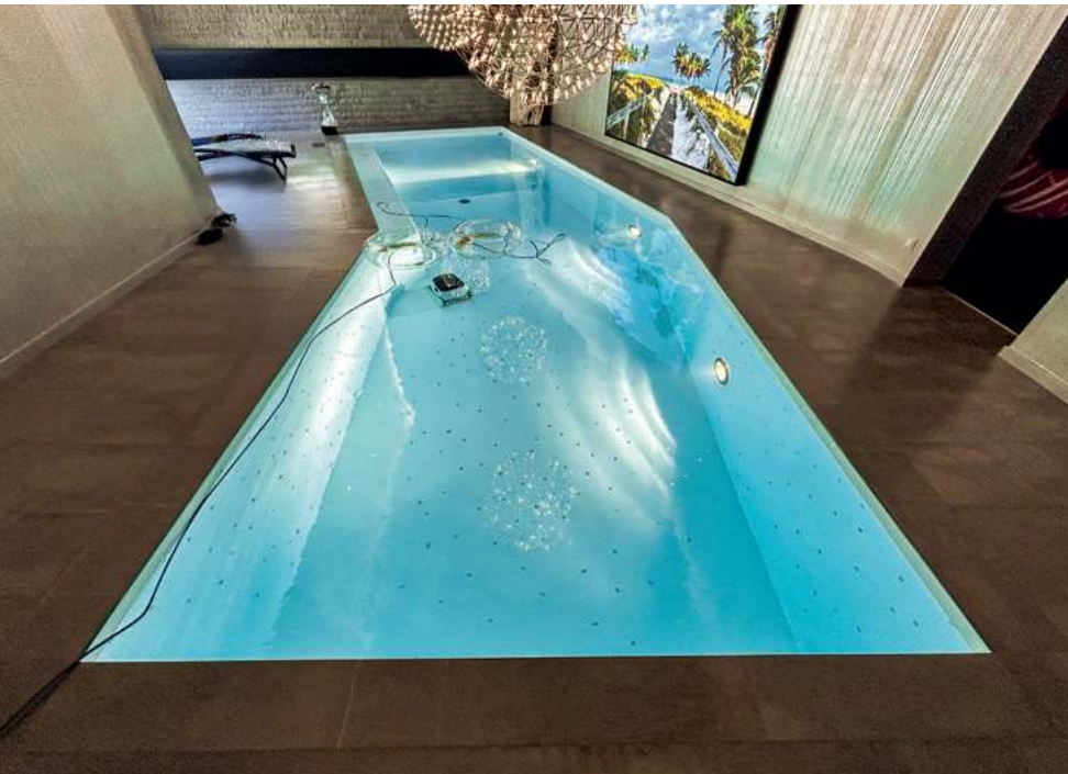
Oben: Zwei neue Treibdüsen verbessern die Beckenhydraulik. Rechts oben: Die Meyer-Pren-Abdichtung legt sich nahtlos wie eine zweite Haut über das Becken und dichtet es sicher ab. Rechts unten: Die Pooltechnik im Untergeschoss.
