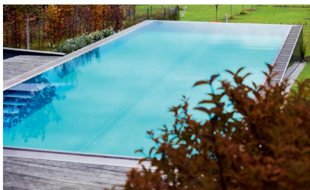
Hochwertige Edelstahlbecken gehören zu den Spezialitäten von A1: Im Bild ein aktuelles Objekt mit Überlaufrinne (siehe auch S. 22ff im Hauptheft).
